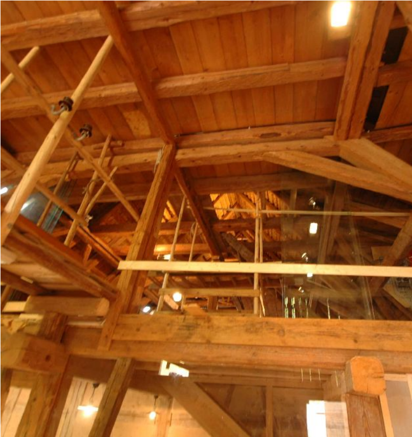
Blick vom Heuboden zum Dachstuhl – Die Glasschiebetüren sind schon eingebaut – die Glasgeländer fehlen noch. Links oben im Bild der alte Steg, der vom hinteren Giebel über den Heuboden führt, und der belassen, gereinigt und statisch gesichert wurde.
