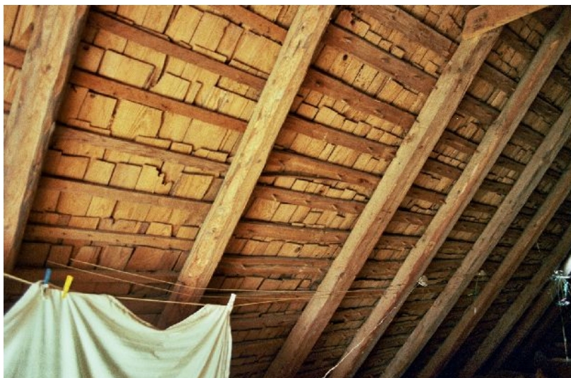
Der neueste Teil des Holzschindeldaches aus dem Jahr 1903
