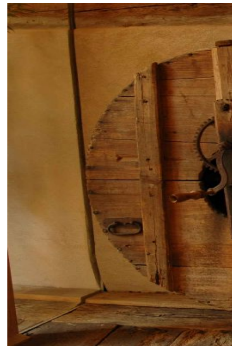
Thermische Trennung in der Tenne – Isolierglas ohne Rahmen an die schiefen Wände und Fußböden angepasst
