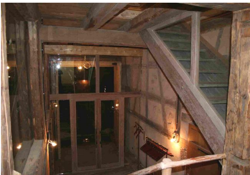
Blick in die Tenne Richtung Tennentor nach der Sanierung
