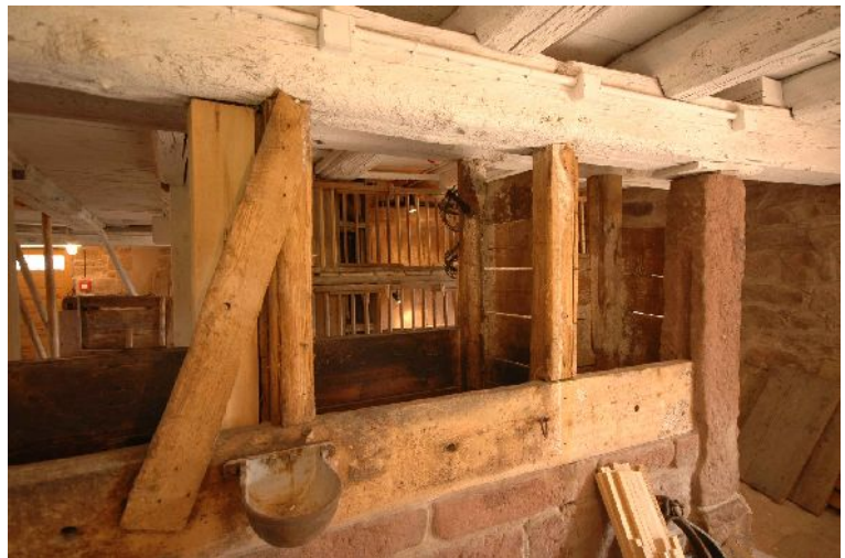
Stall vor der Sanierung. Die Bodenplatten wurden vom Steinmetz ausgebaut, und später wieder eingebaut
