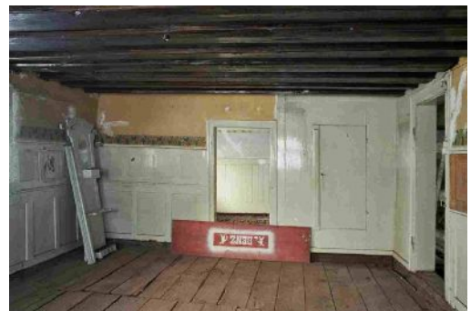
Der untere Bretterboden bildet die Untersichtschalung im Stall
