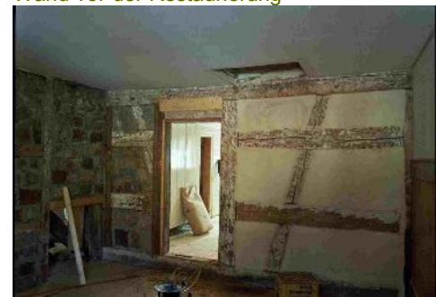
Wand während der Restaurierung. Die Reste des Kalkstrichs sind auf dem Fachwerk sichtbar
