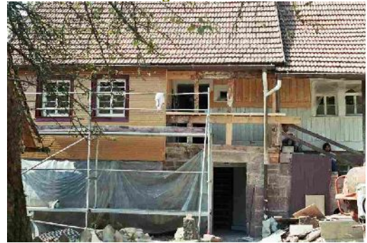
Die Eingangsveranda wird wieder sichtbar .Die alten Balken der Veranda bleiben erhalten
