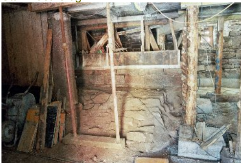
Stall während der Bauarbeiten
