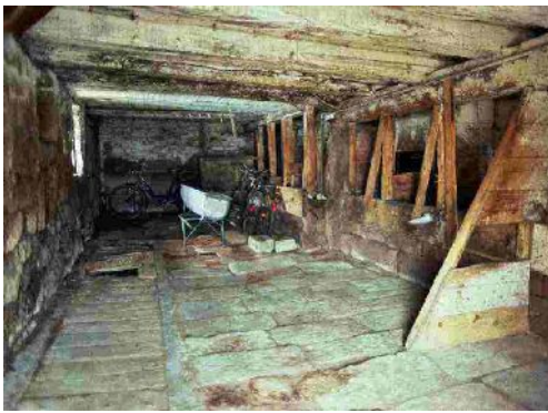
Stall vor der Sanierung. Die Bodenplatten wurden vom Steinmetz ausgebaut, und später wieder eingebaut
