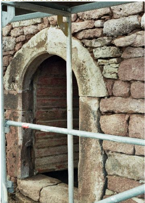
Der Stalleingang während der Restaurierung Reinigung und Neuverfugung der Sandsteine
